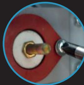
4. Isolierende Gummmatte wieder aufsetzen und die Schrauben festziehen
