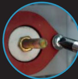
4. Isolierende Gummiratte wieder aufsetzen und die Schrauben festziehen
