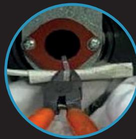
2. Schrauben der Gummiratte lösen und Isoliermatte entfernen.
